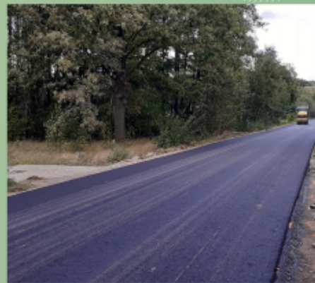
Przebudowa drogi gminnej Nr 131428W w Starym Goniwilku
