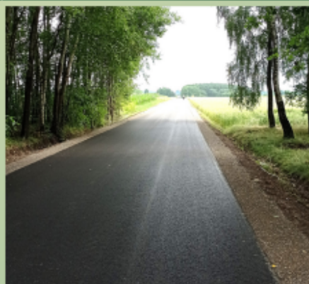
Przebudowa drogi gminnej Nr 131416W w miejscowości Nowy Goniwilk
