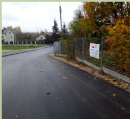
Przebudowa ulicy Sikorskiego w Żelechowie
