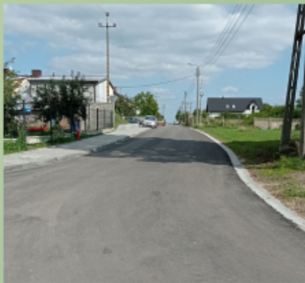
Przebudowa ulicy Pałacowej w Żelechowie
