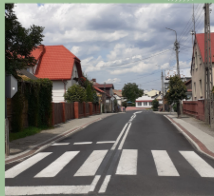
Przebudowa ulic Marszałka Józefa Piłsudskiego i Staszica w Żelechowie
