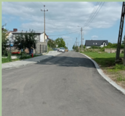
Przebudowa ulicy Pałacowej w Żelechowie
