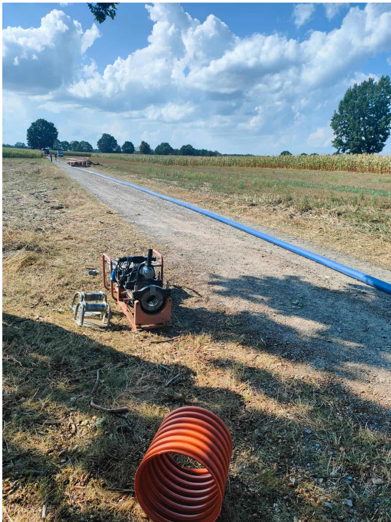
Trwa budowa wodociągu pomiędzy miejscowościami Stefanów - Władysławów.
