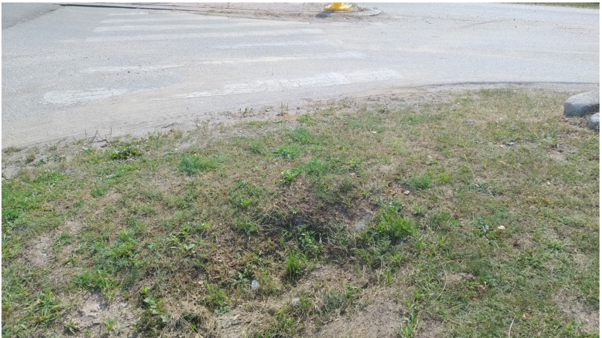
Fot. 26 Droga powiatowa 1337 Gózddek w stronę Łomnicy, stan przepustu pod jezdnią drogi powiatowej.
