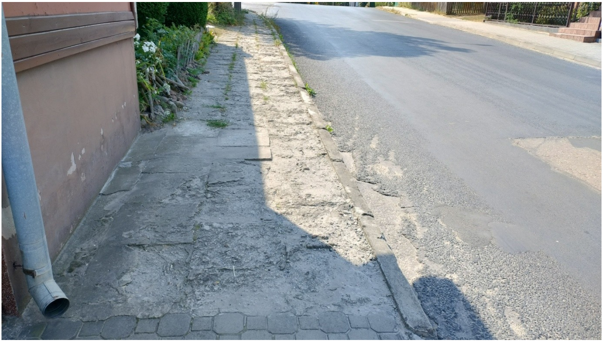
Fot. 5 Droga powiatowa 1330W ul. J. Chłopickiego, chodnik pomiędzy ul. L. Pudły i ul. R. Traugutta (droga powiatowa 1366W).
