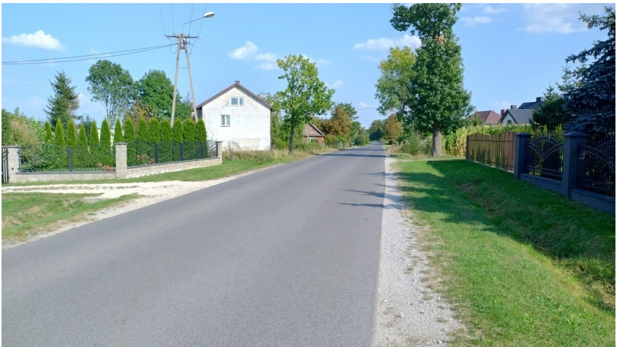
Fot. 8 Droga powiatowa 1328W Nowy Goniwilk, miejsce na budowę chodnika.
