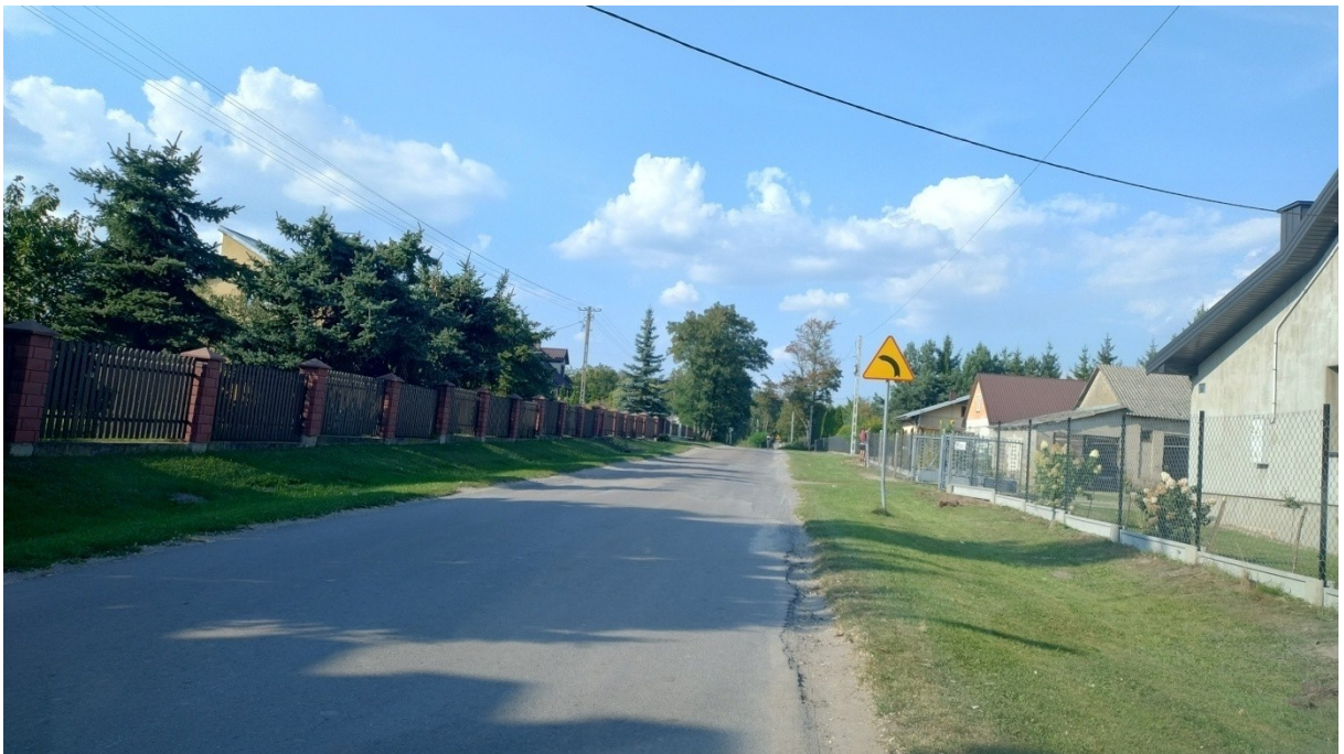
Fot. 32 Droga powiatowa 1338 Stary Goniwilk sytuacja w stronę szkoły, miejsce budowy chodnika.
