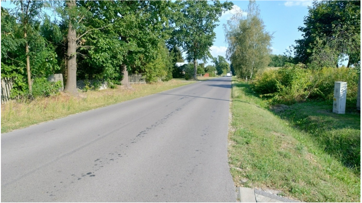
Fot. 7 Droga powiatowa 1328W Nowy Goniwilk, miejsce na budowę chodnika.
