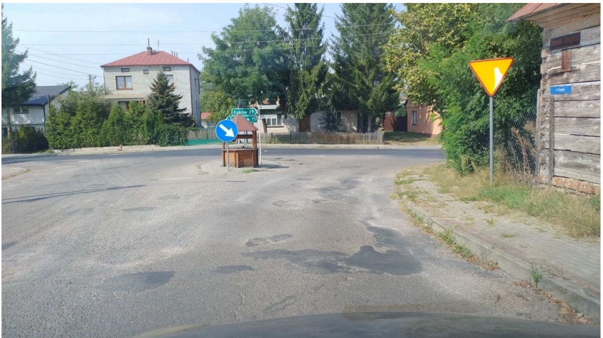
Fot. 4 Droga powiatowa 1366W ul. R. Traugutta, skrzyżowanie z ul. J. Chłpickiego (droga powiatowa 1330W).
