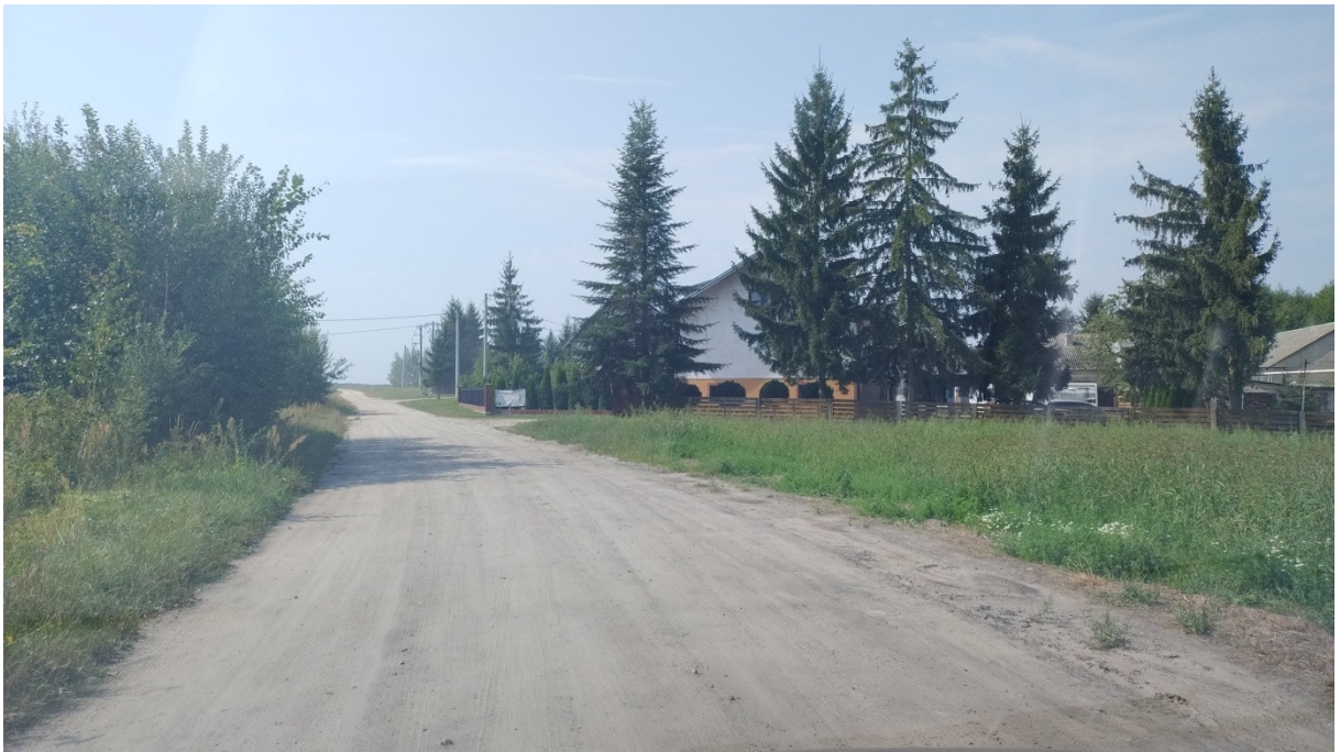
Fot. 11 Droga powiatowa 1365W Stary Kębłów, nawierzchnia utwardzona kruszywem.
