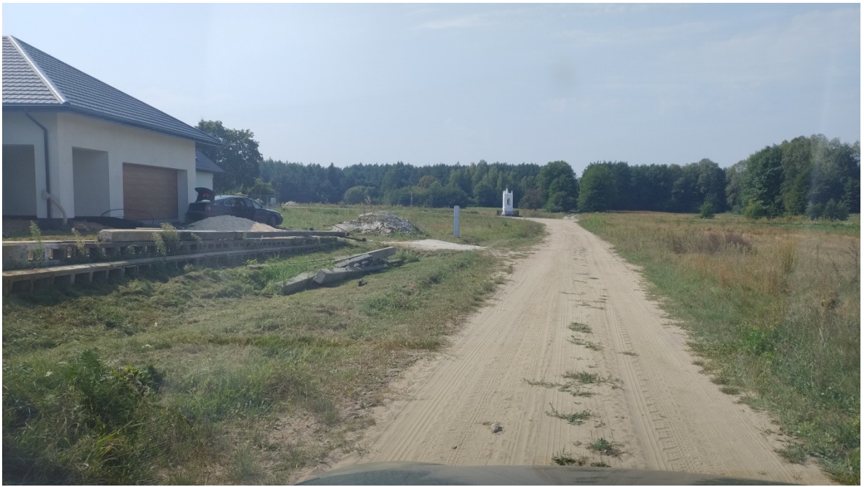
Fot. 13 Droga powiatowa 1365W Stary Kębłów, nawierzchnia gruntowa, zjazd na posesję nowo budowanych domów.
