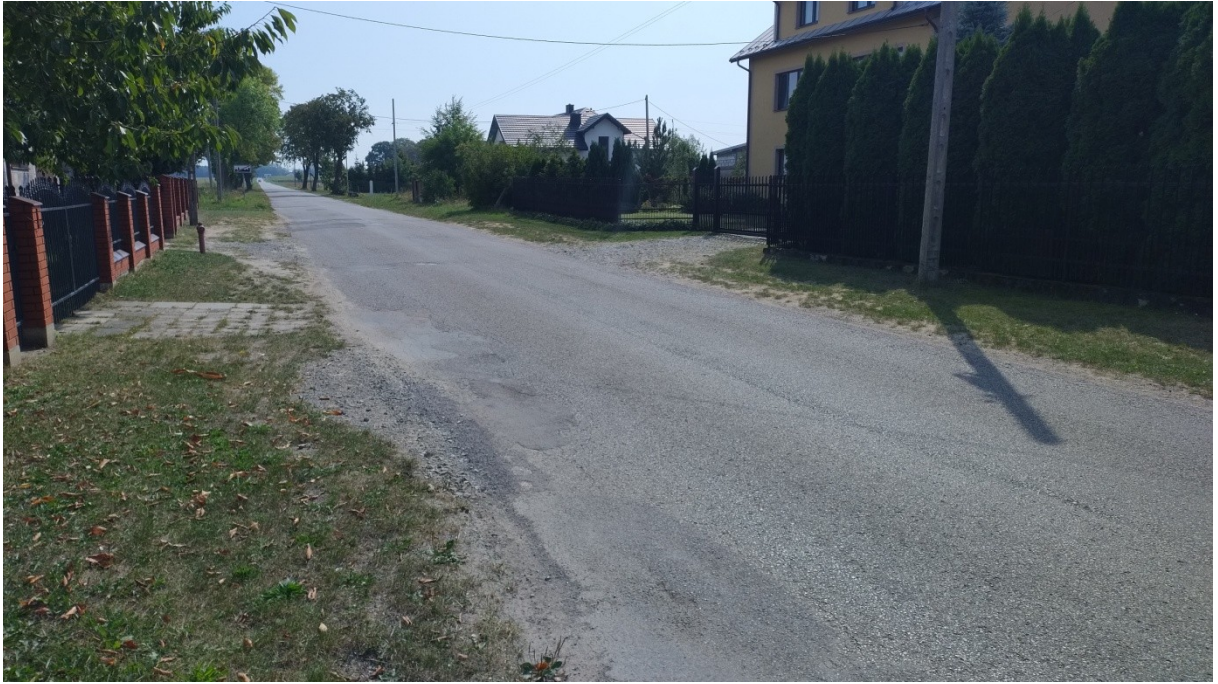
Fot. 29 Droga powiatowa 1369W Al. Wojska Polskiego w stronę Zakrzówka, brak chodników przy zabudowanych posesjach.
