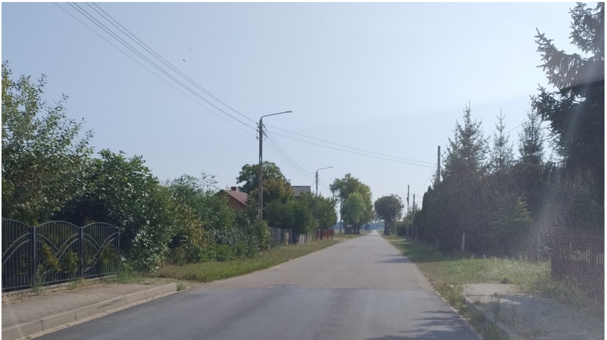
Fot. 27 Droga powiatowa 1369W Al. Wojska Polskiego w stronę Zakrzówka, brak chodników przy zabudowanych posesjach.
