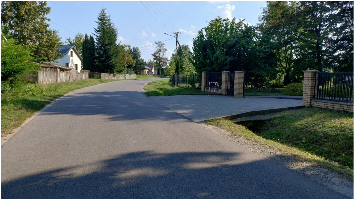
Fot. 31 Droga powiatowa 1338 Stary Goniwilk wjazd do szkoły podstawowej, miejsce budowy chodnika.
