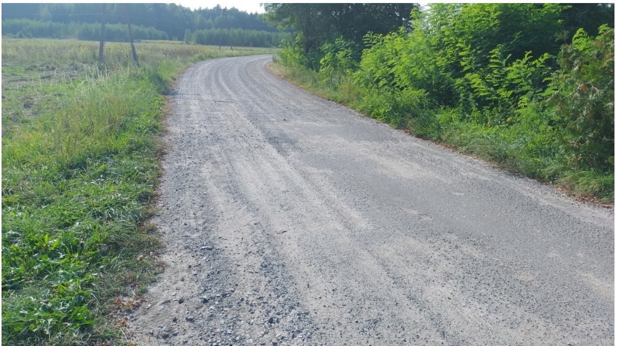
Fot. 24 Droga powiatowa 1338 Kalinów, stan nawierzchni utwardzonej tłuczniem.
