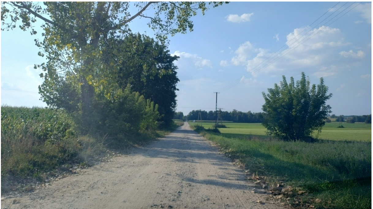
Fot. 30 Droga powiatowa 1336W Huta Żelechowska w stronę granic powiatu, nawierzchnia z Kruszywa.
