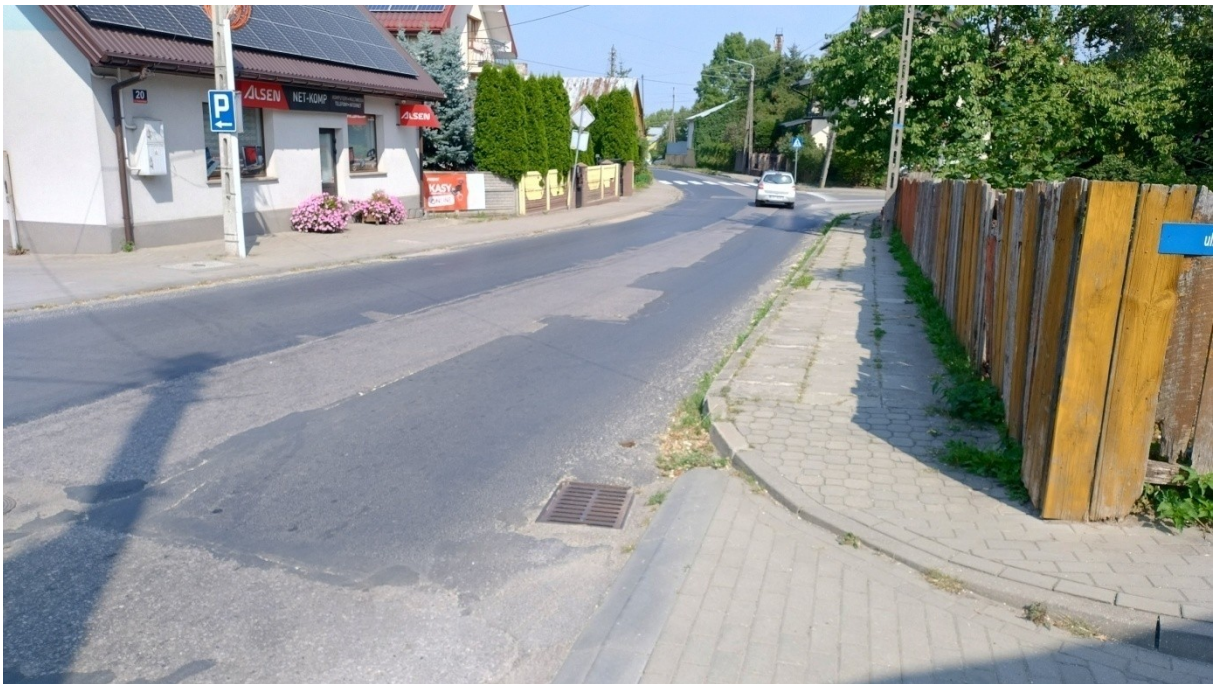
Fot. 6 Droga powiatowa 1330W ul. J. Chłopickiego, odcinek do ul. L. Pudły.
