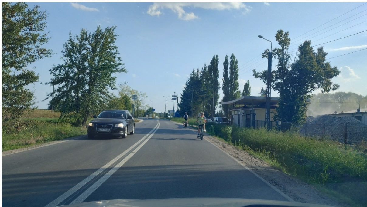
Fot. 1 Droga powiatowa 1366W, ul. R. Traugutta, wyremontowany odcinek bez ścieżki rowerowej.
